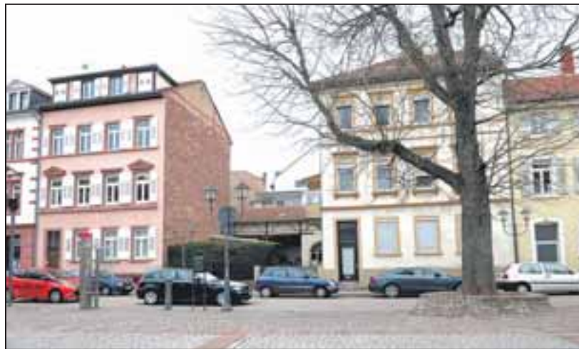
Die Baulücke zwischen der Lutherstraße 15 und 19 direkt am Marktplatz soll überbaut werden. Dort ist ein Hotel mit 27 Zimmern geplant. Foto: Hentschel
